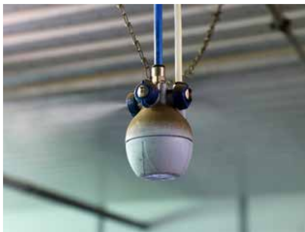
Vier Düsen versprühen den Wassernebel gleichmäßig im Stall. Dieser wird durch ein flüssiges Betriebsmittel und Luftdruck erzeugt. Die Steuerung wird als kompaktes Modul einfach außerhalb des Stalles auf die Wand angeschraubt.
