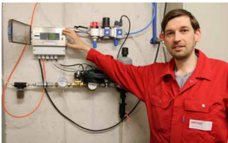
Vier Düsen versprühen den Wassernebel gleichmäßig im Stall. Dieser wird durch ein flüssiges Betriebsmittel und Luftdruck erzeugt. Die Steuerung wird als kompaktes Modul einfach außerhalb des Stalles auf die Wand angeschraubt.
